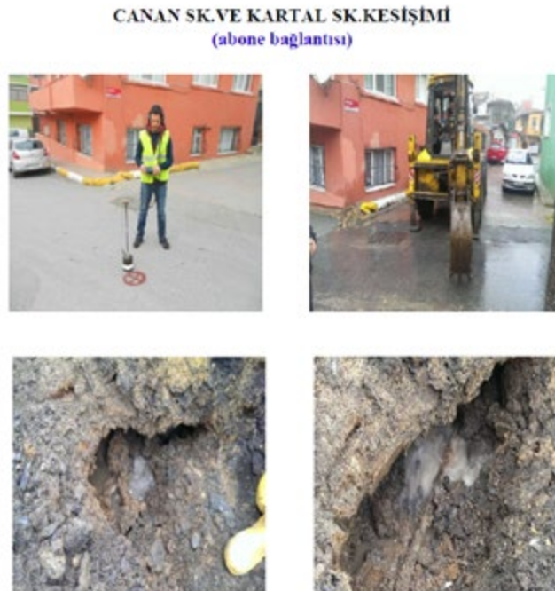
Şekil 30. Sahada gerçekleştirilen aktif kaçak, arıza tespiti ve onarım çalışmaları
