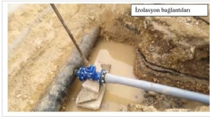
Şekil 33. Sahadaki ÖAB sınırlamalarının yapılabilmesi için yerleştirilen vana çalışmasından örnek (Durmuşçelebi, 2018)
