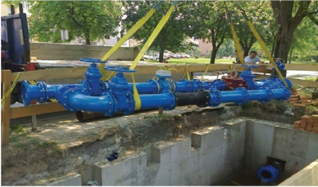
Şekil 24. Oda içerisine elemanların yerleştirilmesi (Hamilton ve McKenzie, 2014)
