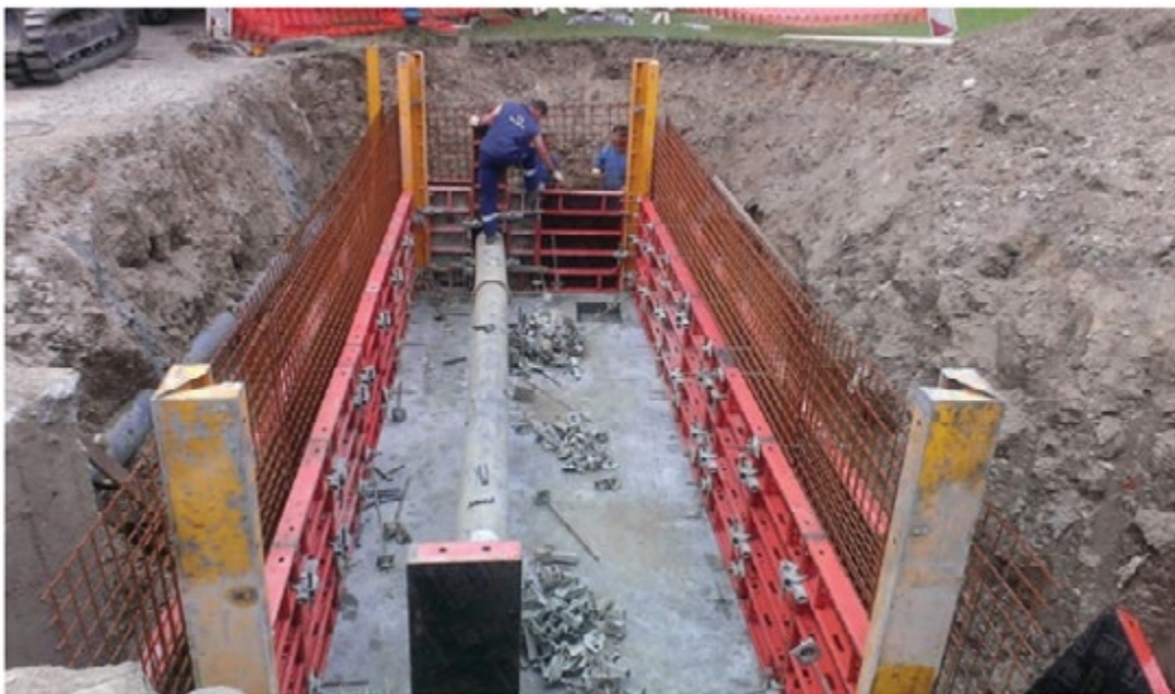
Şekil 23. ÖAB için ölçüm odası yapımı (Hamilton ve McKenzie, 2014)
