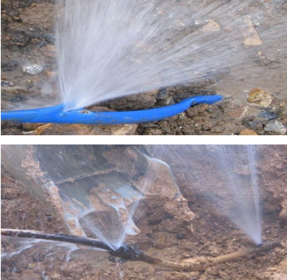
Şekil 11. Servis bağlantılarında meydana gelen sızıntılar (Boztaş vd., 2018)
