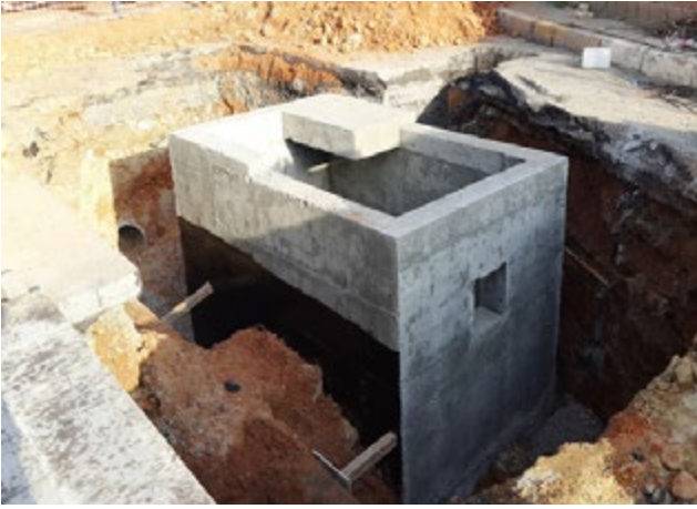
Şekil 27. Ölçüm odalarının sahada imalatı
