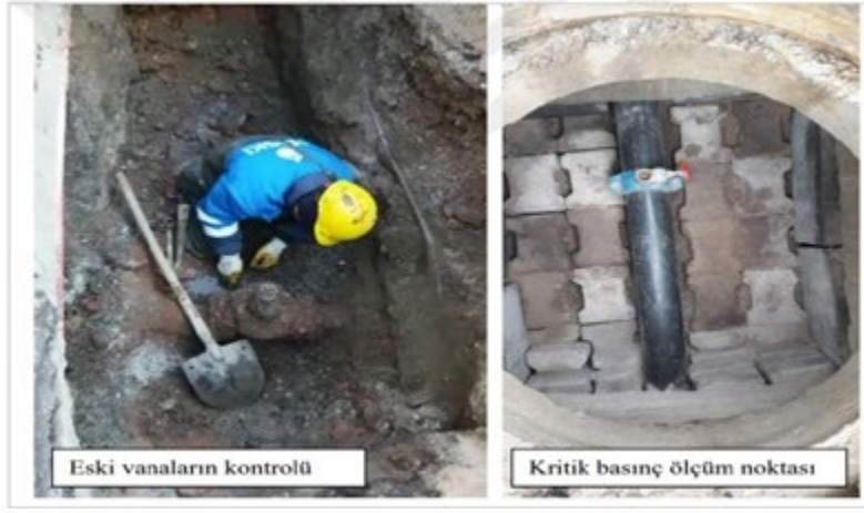
Şekil 32. ÖAB oluşturulması için sahada yapılan çalışmalar (Durmuşçelebi, 2018)
