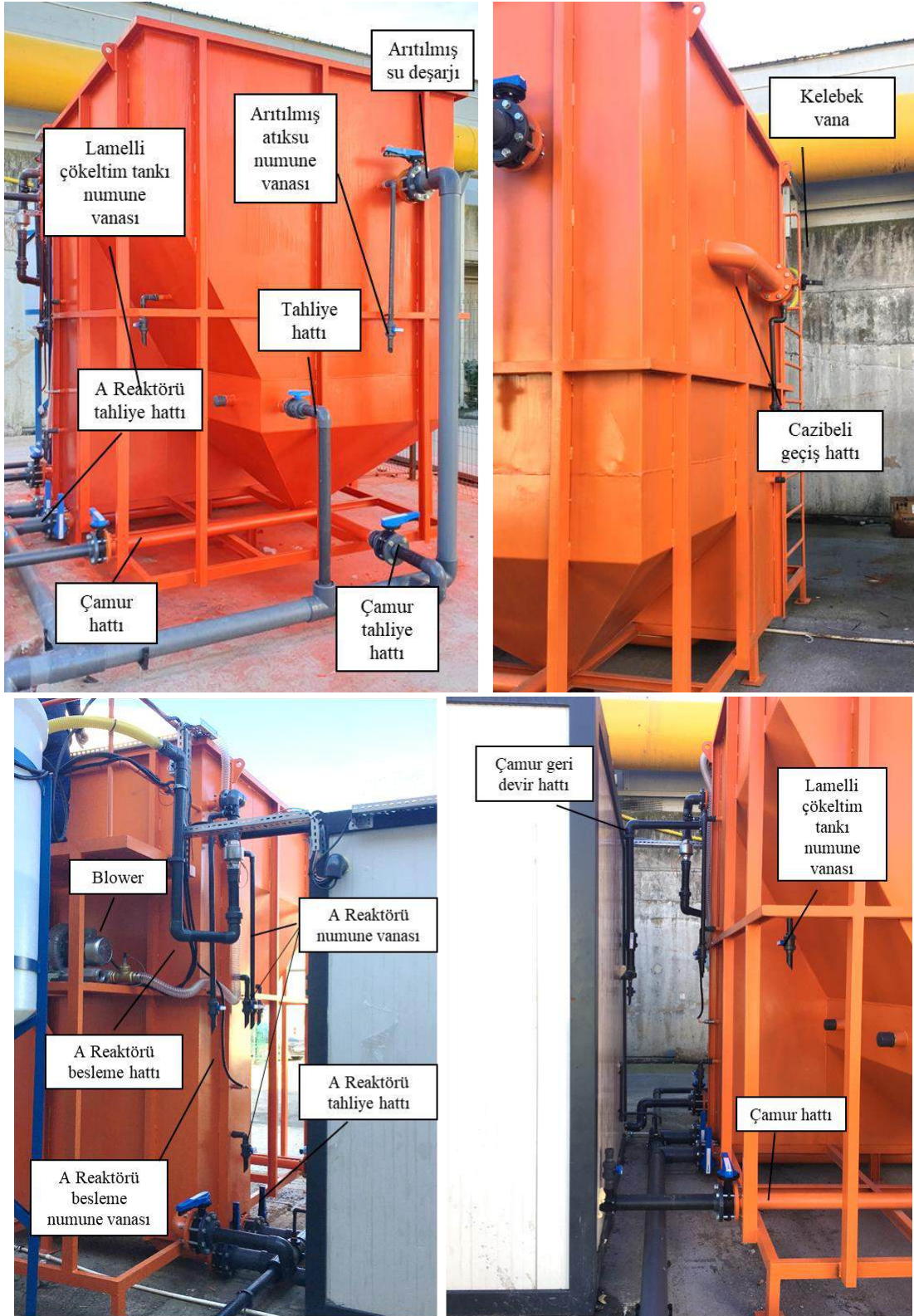
Pilot ölçekli YYAÇ sistemi - A reaktörü ve Lamelli çökeltim tankı - İSKİ Baltalimanı Ön AAT, İstanbul (A reaktörü: en = 0,8 \text{ m} , boy = 2,2 \text{ m} , yükseklik = 2,9 \text{ m} ( V_{toplam} = 5,1 \text{ m}^3 , V_{etkin} = 4 \text{ m}^3 Reaktör tabanında 270 mm çaplı 21 adet difüzör, 60^\circ açı ile yerleştirilmiş lameller arası boşluklar 10 cm)
