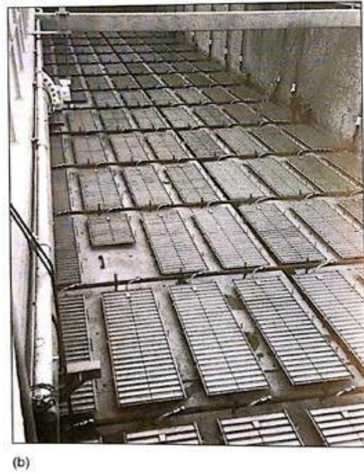
Şekil 7-2. Ultra ince gözenekli membran havalandırma panelleri (a) şematik (Courtesy Parkson Corp. (ABD)) (b) Aktif çamur sisteminin altında yerleştirilen paneller (Tchobanoglous vd. 2003)
