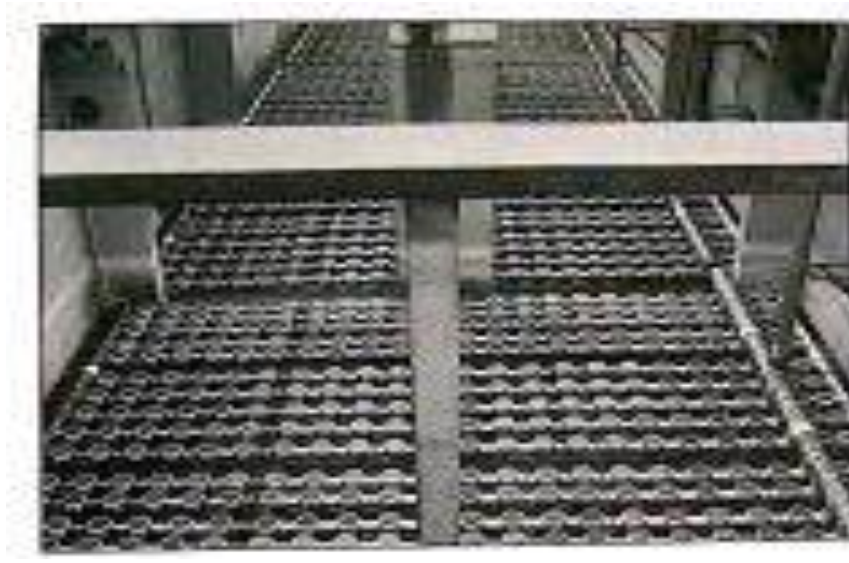
Şekil 7-1. Bombe havalandırıcılı piston akımlı havalandırma tankı (Tchobanoglous vd. 2003)
